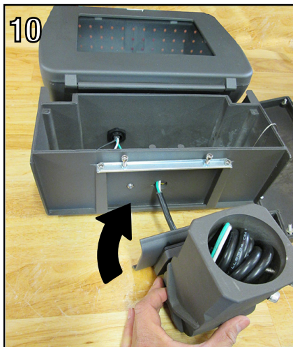
Insérer le filage électrique à l'intérieur du luminaire.
